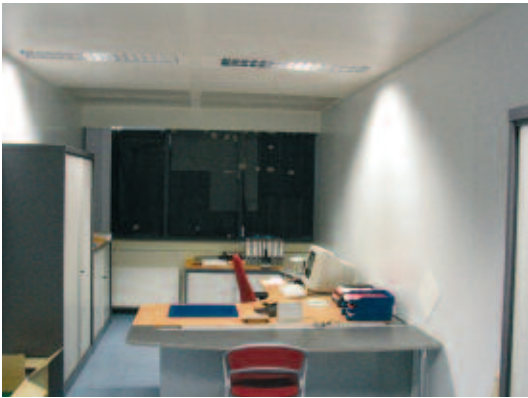
Figuur 33 : Afscherming van de vensteropening d.m.v. afdekzeilen
